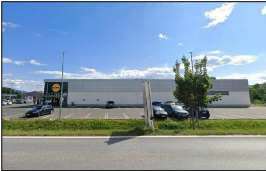
Blick auf die Nordfassade des Verbrauchermarktes (Quelle: Google Maps)
