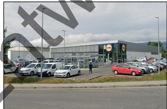
Blick auf die Nordostfassade des Verbrauchermarktes (Quelle: Google Maps)
